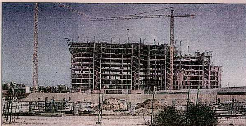
Bloque de viviendas en proceso de construcción. / BLOOMBERG
