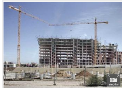
Bloque de viviendas en proceso de construcción. - BLOOMBERG
